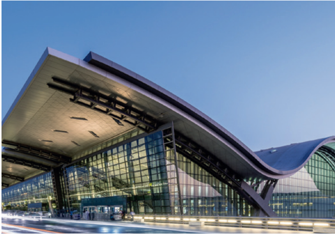
AÉROPORT INTERNATIONAL DE HAMAD DOHA, QATAR
