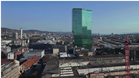
Prime Tower Zürich, Schweiz
